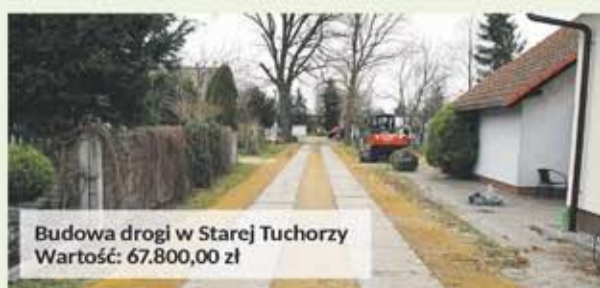
Budowa drogi Jaromierz Dofinansowanie: 172.650,00 zł Wartość: 530.792,00 zł
