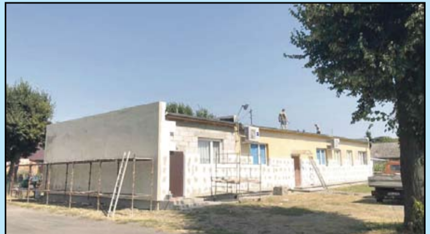
Przebudowa świetlicy wiejskiej w Reklinie
